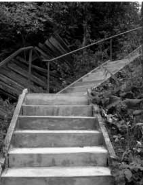
Dolní část schodů z ul. Svatopluka Čecha směrem k silnici
