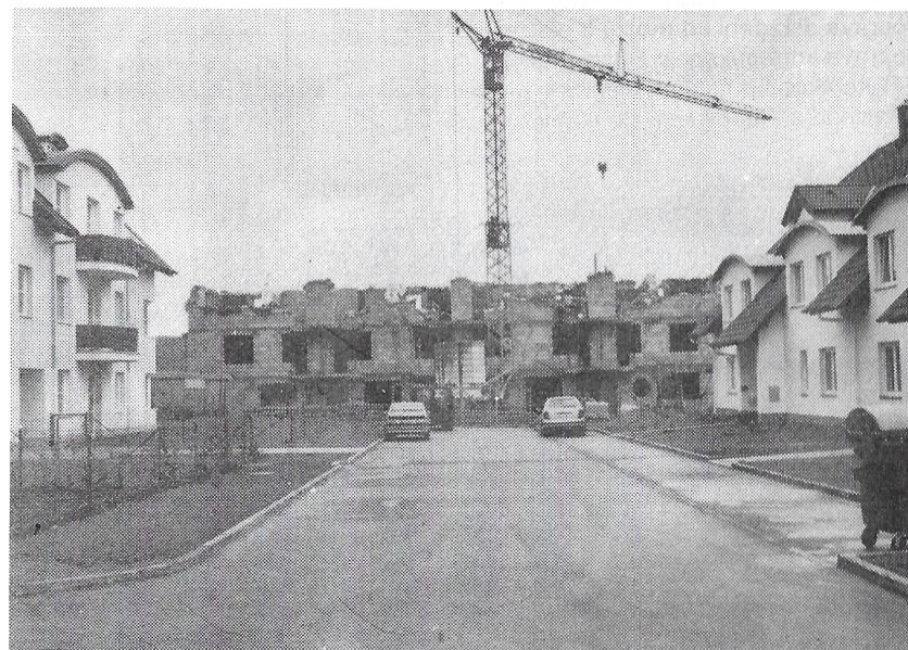
Lesní, stavba domu B3,3
