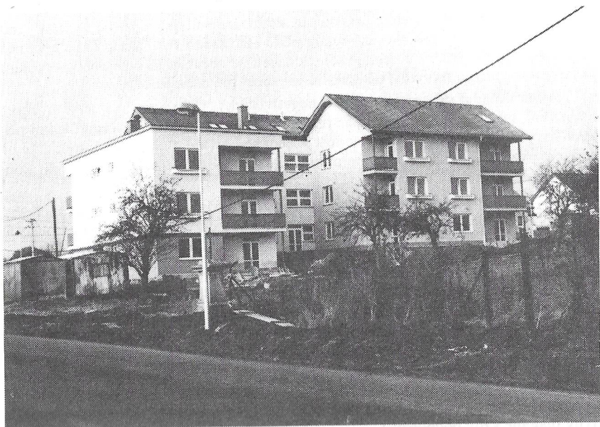
Ulice Vodárenská - dvacetbytových jednotek. Foto B. Zlámal
