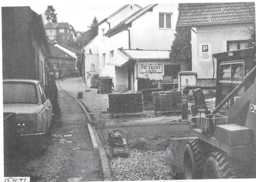
Ulice Husova - práce na pokládání zámkové dlažby. Foto B. Zlámal
