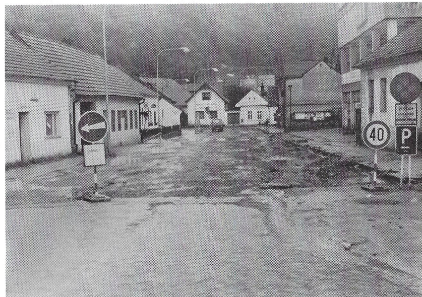
Ulice Žižkova, po odstranění krytu vozovky; značky na usměrnění dopravy
