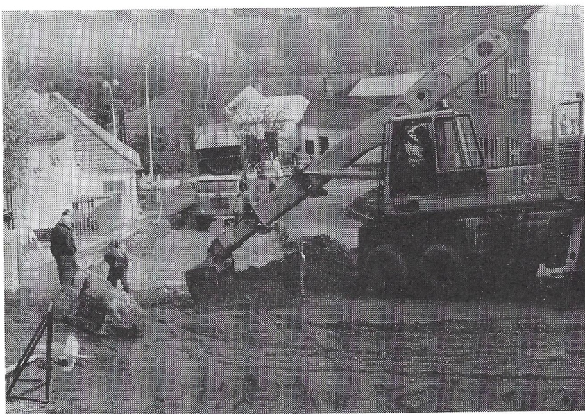
Ulice Žižkova - výkop „kufru“ = spodní stavba, ve druhé etapě
