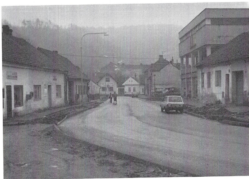
Ulice Žižkova - vozovka po opravě
