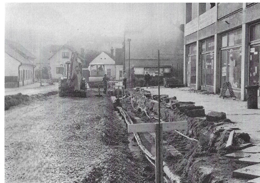
Ulice Žižkova, přeložky kabelů a rozprostření rakadanu na polovině vozovky
