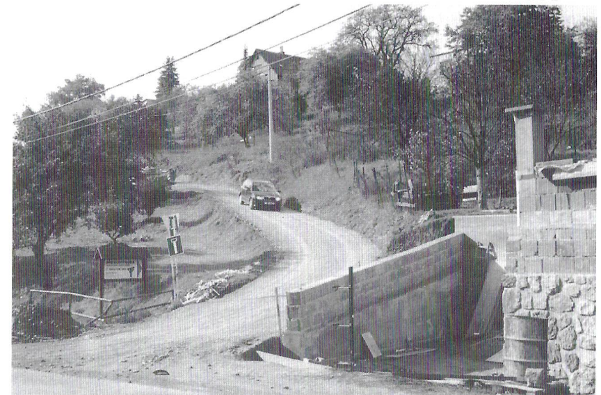
Z Havlíčkově na Nivky nová vozovka. Foto: B. Zlámal
