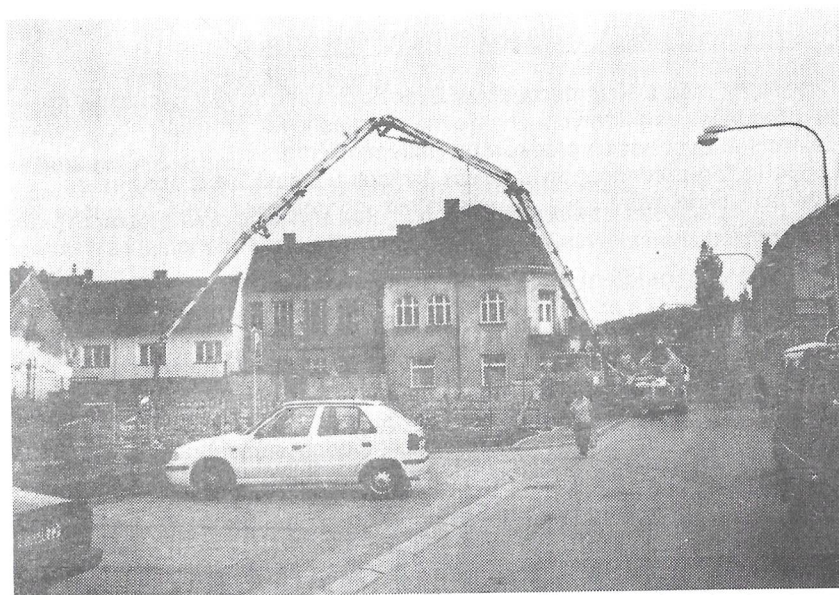
Betonáž základů DPS. Foto: Vilém Kleveta
