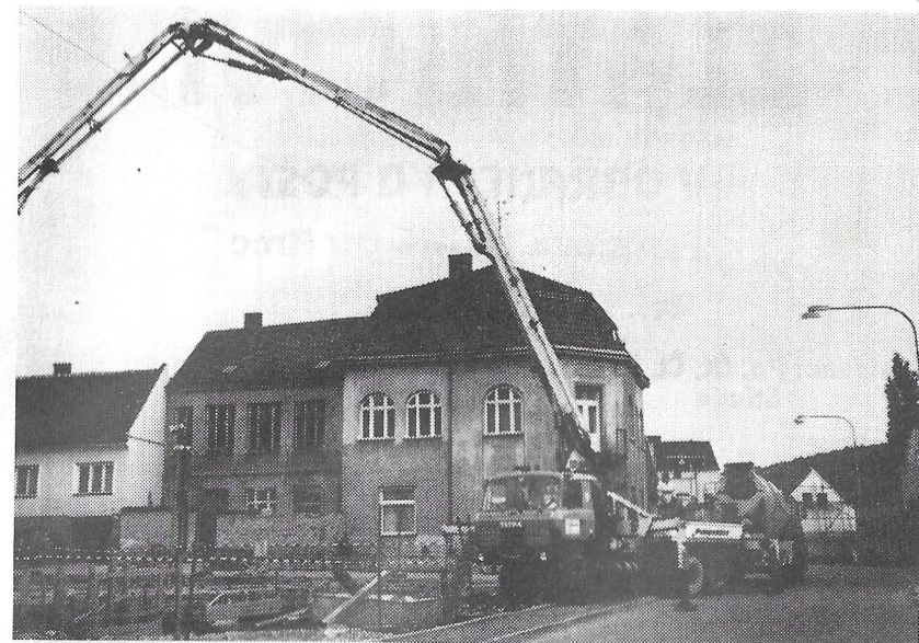
Betonáž základů DPS. Foto: Vilém Kleveta
