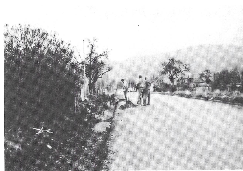
Obřanská ulice. Práce na budování chodníku k ulici Vodárenské. Foto B. Zlámal
