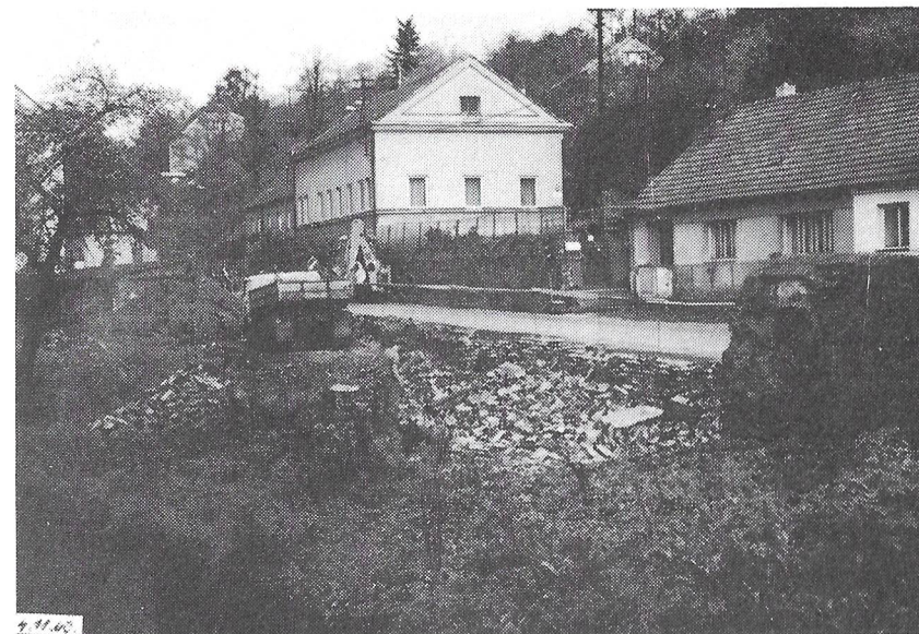
Fügnerovo nábřeží. Bourání zdi mezi silnicí a mlýnskou zahradou za účelem rozšíření vozovky. Foto B. Zlámal.
